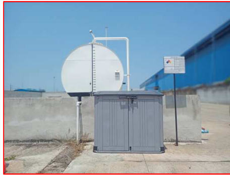
ภาพที่ 2-61 ตู้อุปกรณ์จัดการกรณีน้ำมันหกรั่วไหล
