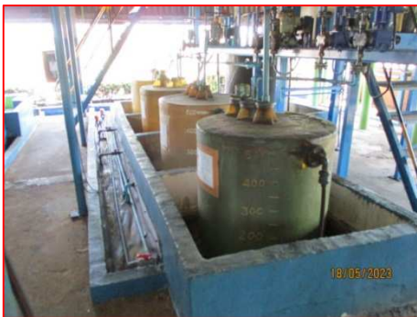
ภาพที่ 2-56 คันคอนกรีตรอบบริเวณถังน้ำมันและถังบรรจุสารเคมี
